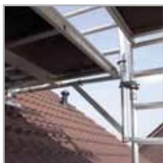
Bevestiging console aan steigerframe
