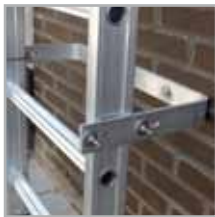
Muursteen uitgevoerd in U-vorm en voorzien van sleufgaten kunnen op elke gewenste hoogte worden aangebracht
