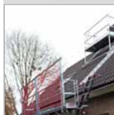
Veilige opbouw met behulp van Modulaire Triangelbrug (MTB) met Dakrandbeveiliging
