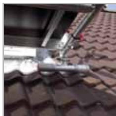
Stempel voorzien van kunststof bescherming
