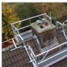
SchoorsteenSteiger-nokhaak is in te stellen voor een hoek van 30-45 graden
